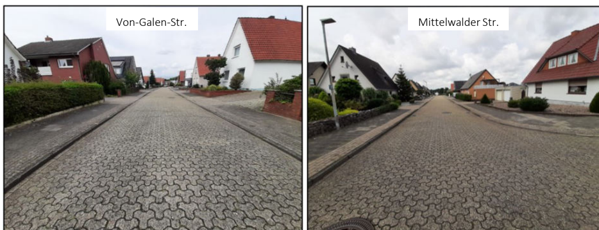
Abbildung 84: Versiegelte Straßenzüge (Eigene Aufnahmen)
