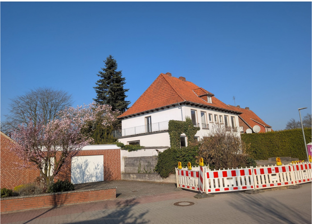
Abb. 3: Mehrfamilienhaus an der Kreuzstraße mit altem Ziegeldach.
