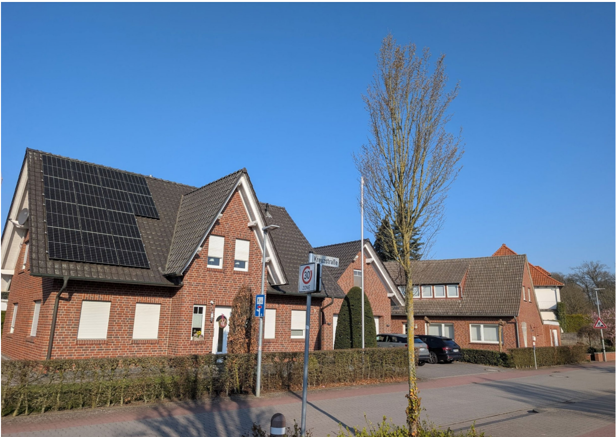
Abb. 4: Neubau an der Ecke Kreuzstraße / Klapphakenstraße.
