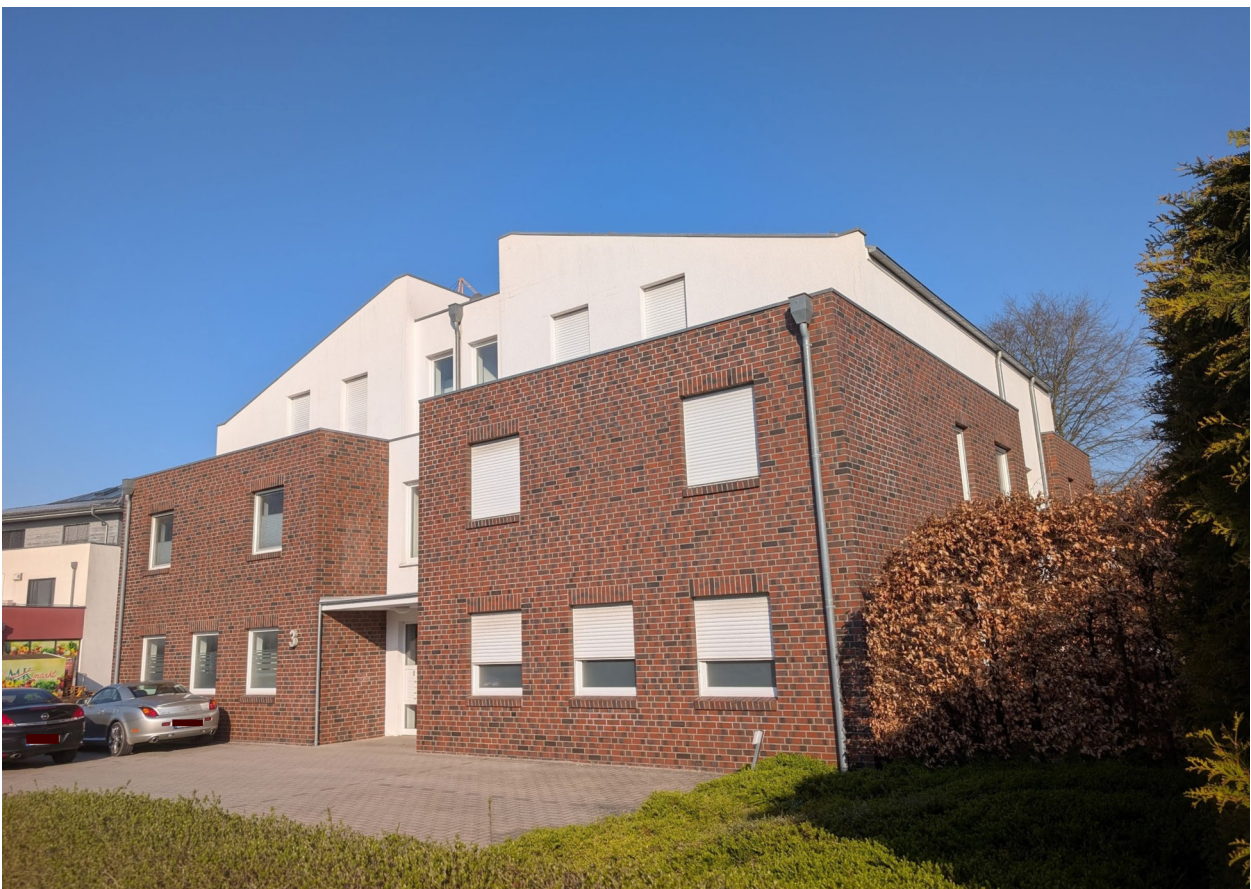
Abb. 5: Neubau an der Klapphakenstraße.
